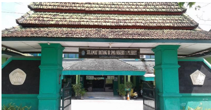
Gambar Gerbang SMA N 1 Pleret Bantul
